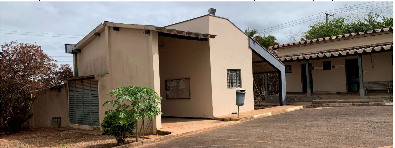
Vista da portaria
