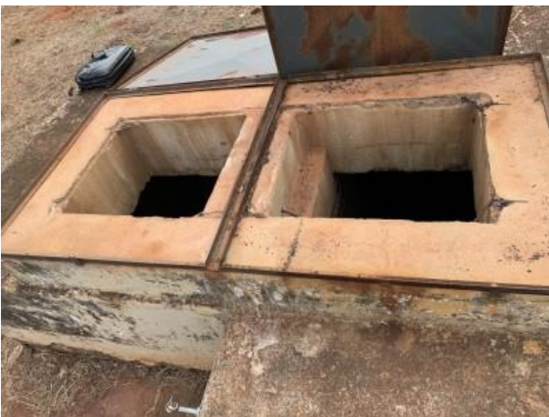
FOTO 62 ACESSO RESERVATÓRIO ENTERRADO
