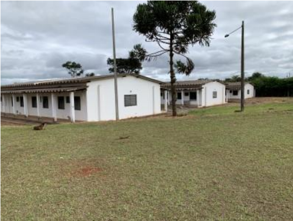
FOTO 56 VISTA DOS BLOCOS 3, 2 E 1 RESPECTIVAMENTE
