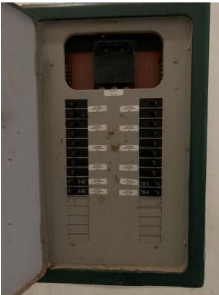
FOTO 29 PORTA ABERTA COM PROTEÇÃO CONTRA CONTATOS DIRETOS
