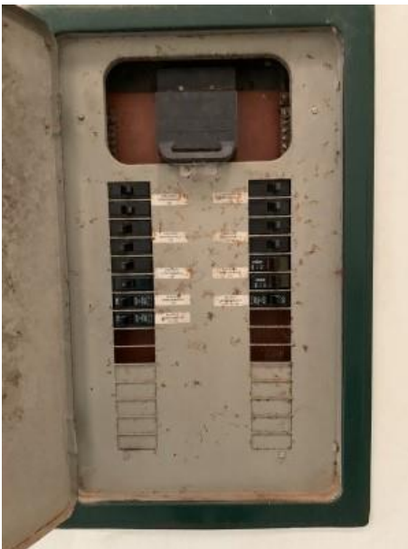
FOTO 20 PORTA ABERTA COM PROTEÇÃO CONTRA CONTATOS DIRETOS
