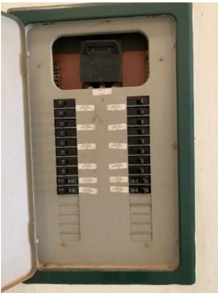
FOTO 23 PORTA ABERTA COM PROTEÇÃO CONTRA CONTATOS DIRETOS
