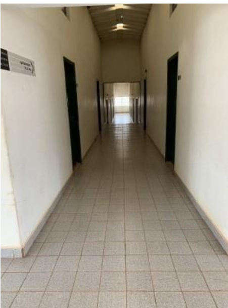
FOTO 50 CORREDOR DO BLOCO 2
