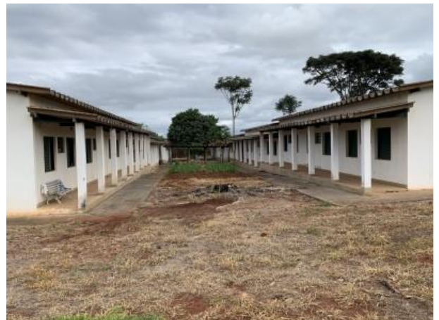
FOTO 59 VISTA ENTRE BLOCOS 2 E 1 RESPECTIVAMENTE
