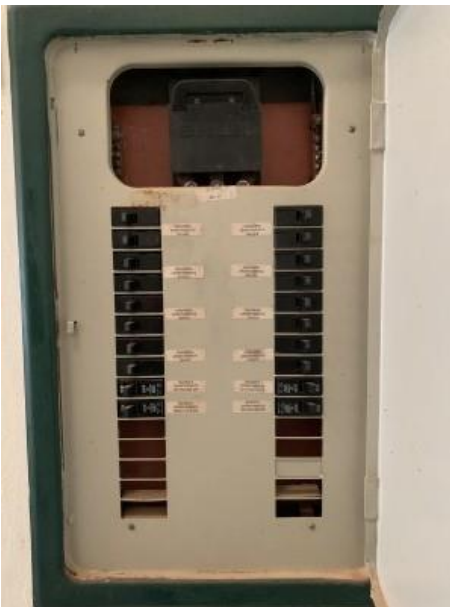
FOTO 32 PORTA ABERTA COM PROTEÇÃO CONTRA CONTATOS DIRETOS
