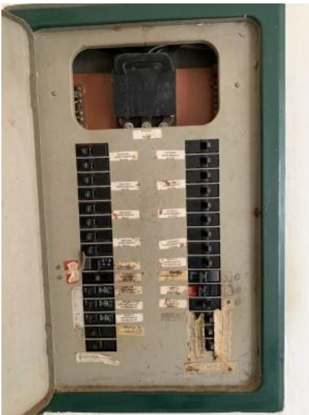
FOTO 35 PORTA ABERTA COM PROTEÇÃO CONTRA CONTATOS DIRETOS
