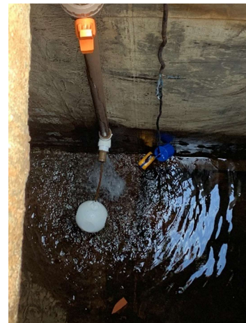
Casa de bombas de recalque e torneira de boia de alimentação d'água.
