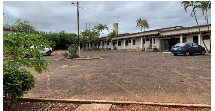
Vista do pátio da entrada principal
