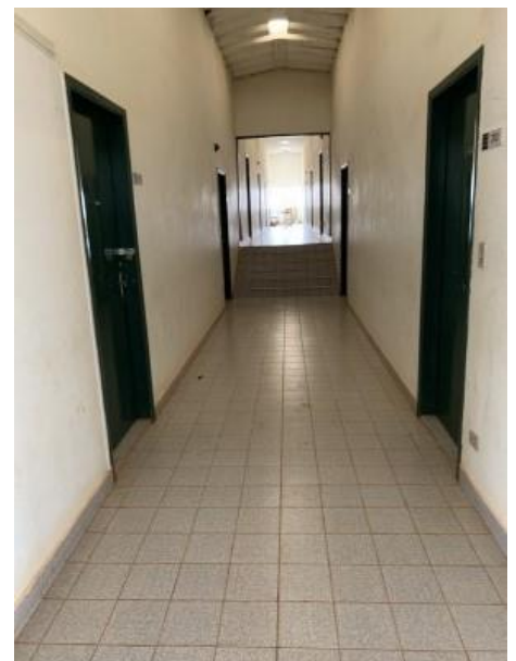
FOTO 51 CORREDOR DO BLOCO 2
