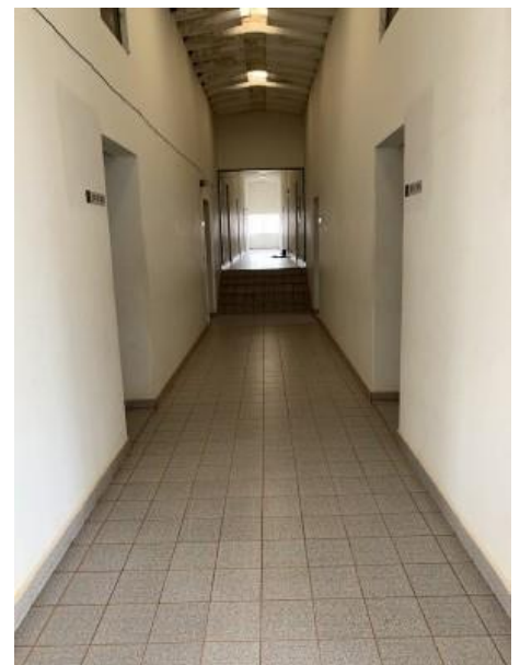
FOTO 55 CORREDOR DO BLOCO 3
