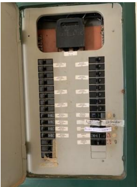
FOTO 26 PORTA ABERTA COM PROTEÇÃO CONTRA CONTATOS DIRETOS
