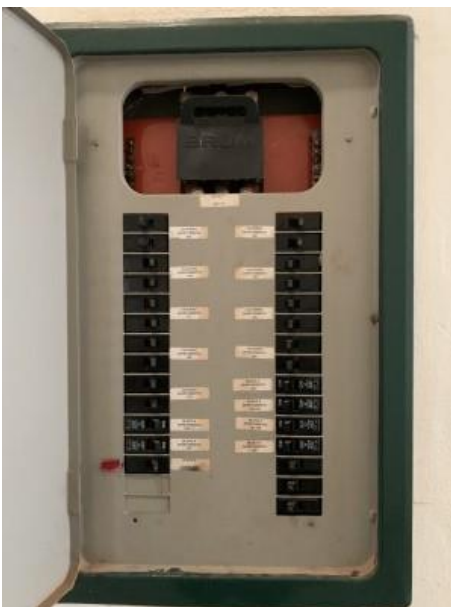
FOTO 14 PORTA ABERTA COM PROTEÇÃO CONTRA CONTATOS DIRETOS
