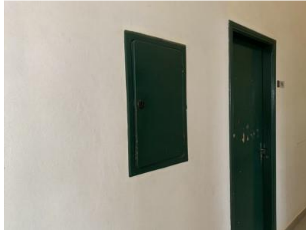
FOTO 16 LOCALIZAÇÃO PORTA FECHADA
