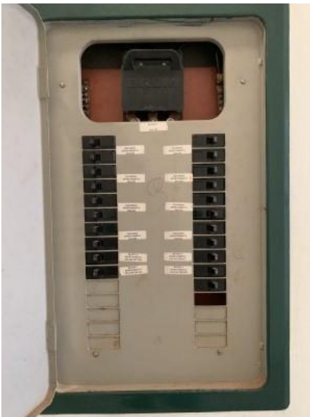
FOTO 38 PORTA ABERTA COM PROTEÇÃO CONTRA CONTATOS DIRETOS
