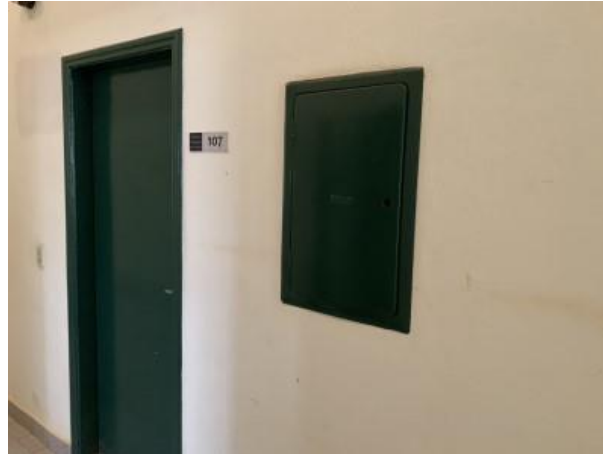
FOTO 13 LOCALIZAÇÃO PORTA FECHADA
