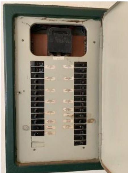
FOTO 17 PORTA ABERTA COM PROTEÇÃO CONTRA CONTATOS DIRETOS
