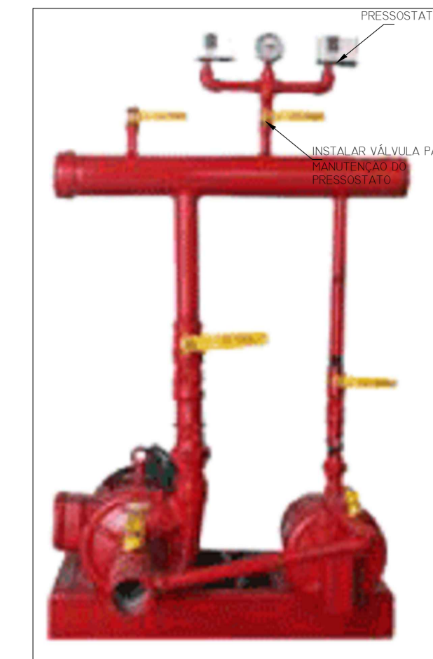
DETALHE ILUSTRATIVO INSTALAÇÃO DE PRESSOSTATO SEM ESCALA
